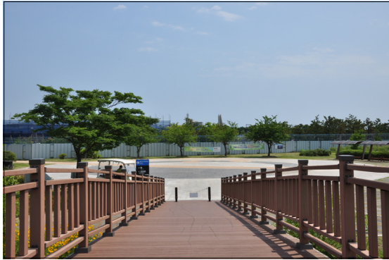
〈그림 5-22〉 국립을숙도청소년수련원 공사현장
